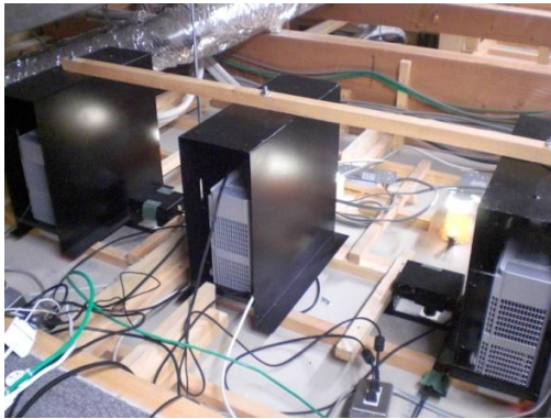
(b)天井裏のカメラとプロジェクタの設置状況 図 2 キッチンに設置したカメラとプロジェクタ
